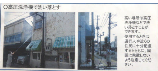
○高圧洗浄機で洗い落とす
