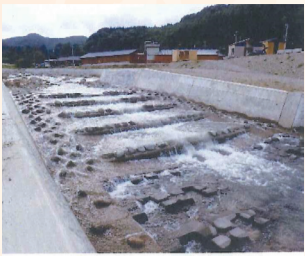
(桧沢川4号床止完了)
