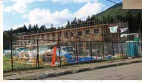
建設中の 寄宿舎
